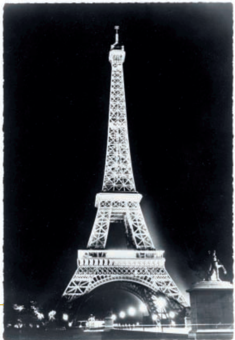
Der Eiffelturm in Paris, im Mai 1958. Er wird von 170 3kW-Scheinwerfern angestrahlt.
